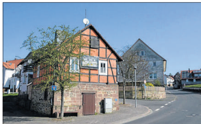
Das Backhaus Obergrenzebach: Im Untergeschoss wird Brot gebacken, darüber treffen sich die Jugendlichen in ihrem Club.
